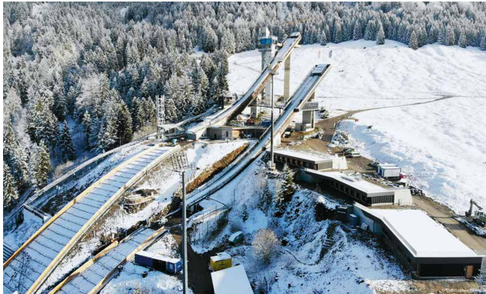
Umbaumaßnahmen an der Schanze trotz Schnee: Der Athletenbereich wurde neu erstellt und zwei neue Kleinschanzen ersetzen die alten.
