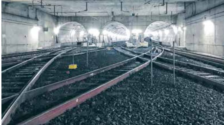
Auch die Wendeanlage im Frankfurter U-Bahn-Tunnel der VGF war Teil der Bauarbeiten innerhalb der kurzen Sommersperrpause.
