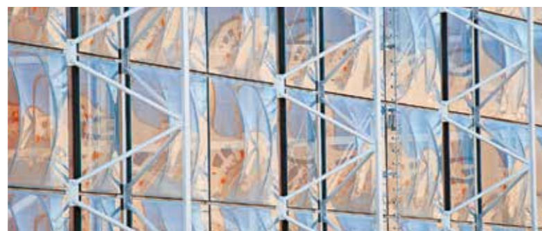
Fig. 21: Membrane façade Source: ENERGIEWENDEBAUEN
