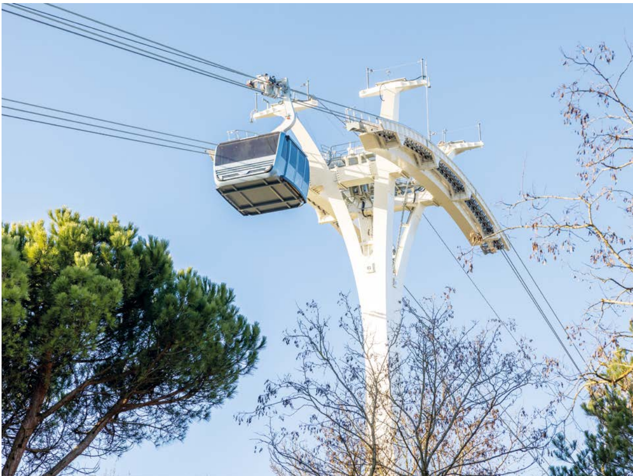
Téléphérique Urbain Sud 3S system in Toulouse, France
